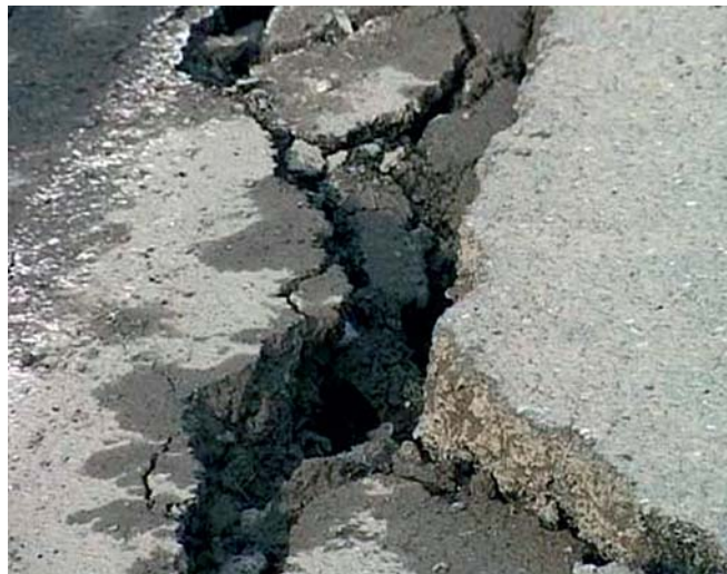
Провал в районе железорудной шахты «Северопесчанская» Богословского РУ (а) и трещина в дорожном полотне (б)
