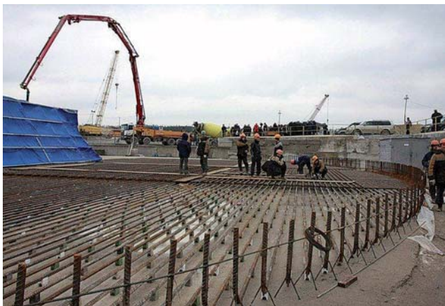
Строительство Балтийской АЭС
